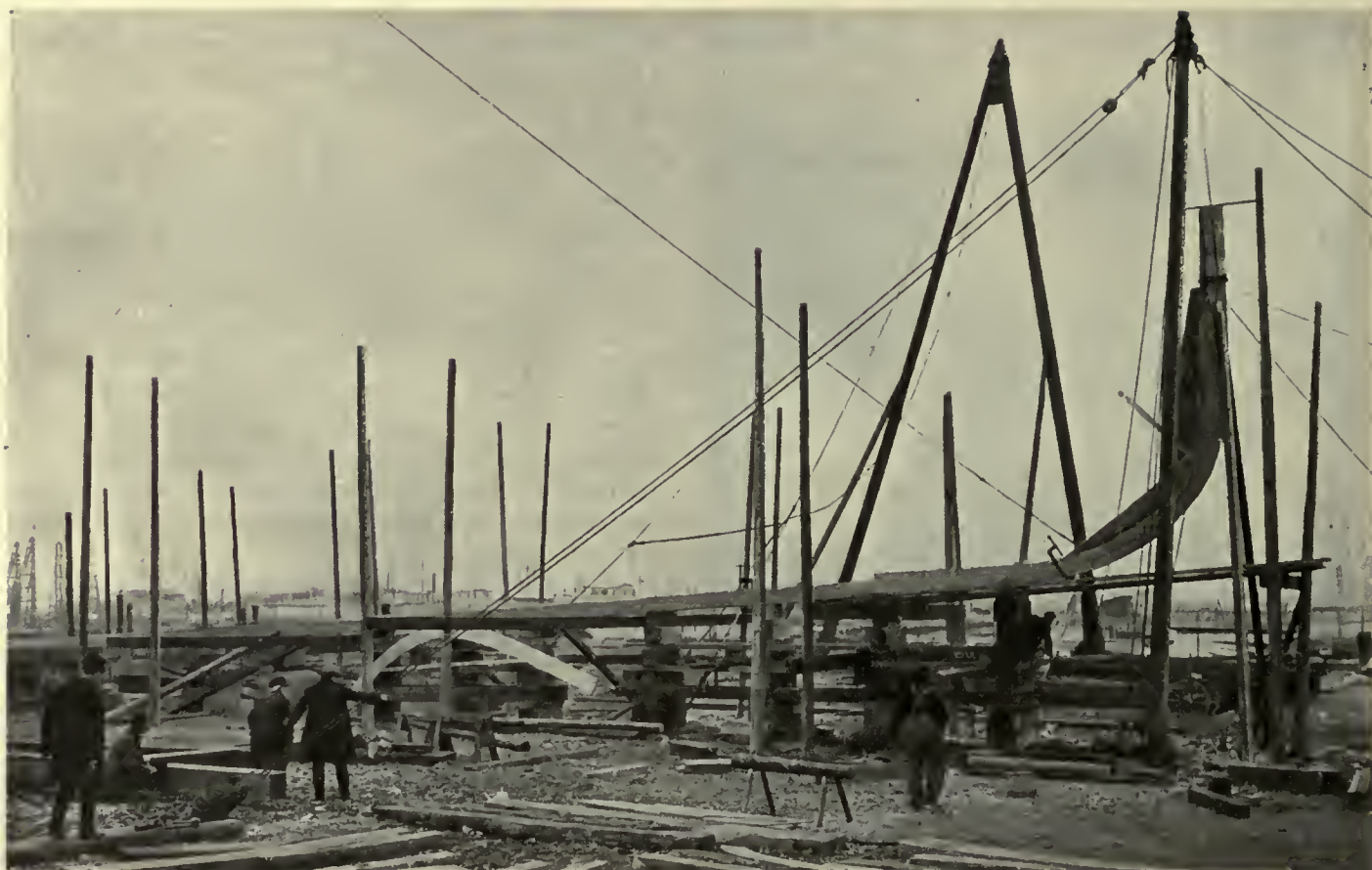
Fig. 30. Keel Set Up
