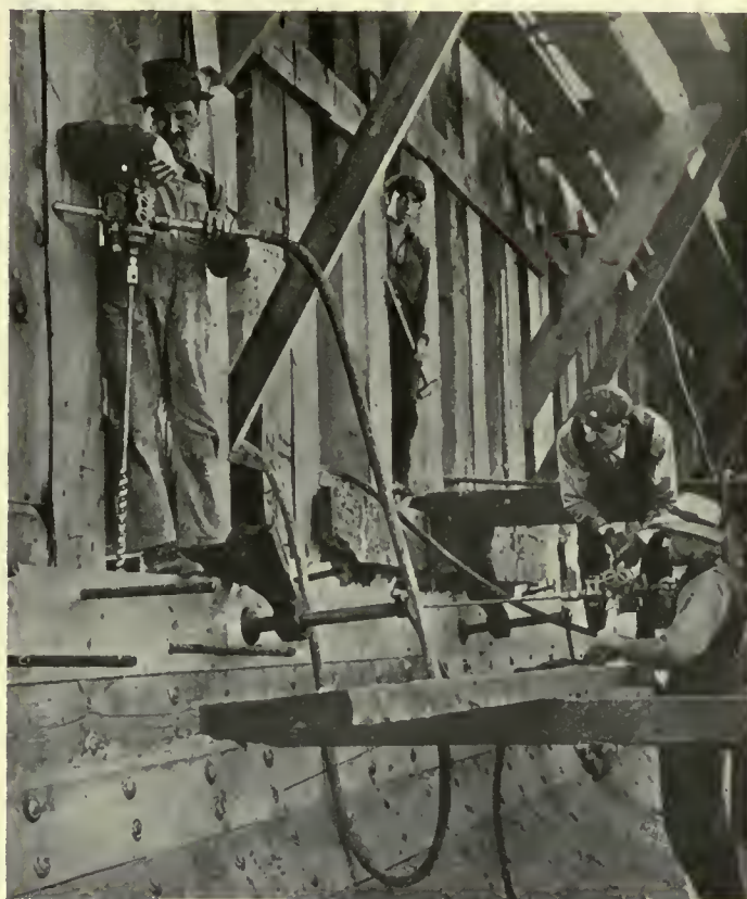
Fig. 43b. Edge Bolting Ceiling
