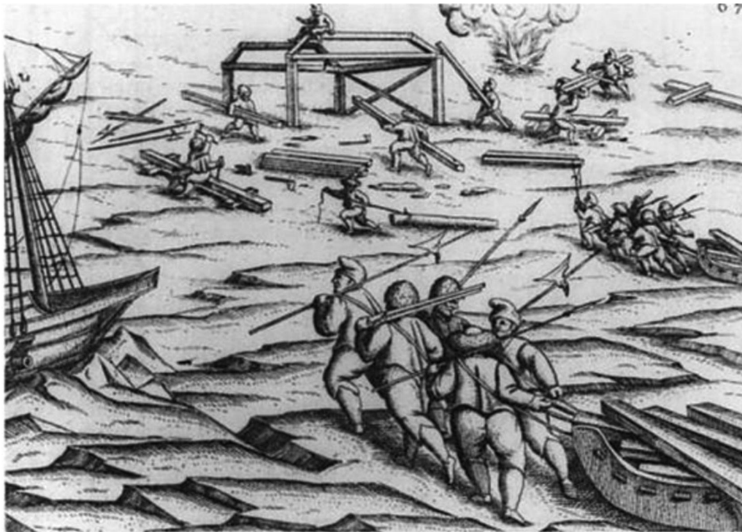
Afbeelding 3. De bouw van het Behouden Huys. De mannen gebruiken het gereedschap van de scheepstimmerman om het huis te bouwen. Op zelfgefabriceerde sleden slepen ze balken naar de bouwplaats, gewapend, uit angst door beren aangevallen te worden. Gravure in: Gerrit de Veer. Warhaftigc Relation (...). Neurnberg 1398.
